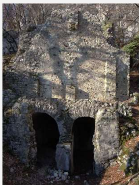
Vodni stolp na Svetem Pavlu nad Vrtovinom
