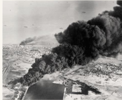
Goreči rezervoarji nafte ob Sueškem prekopu.
