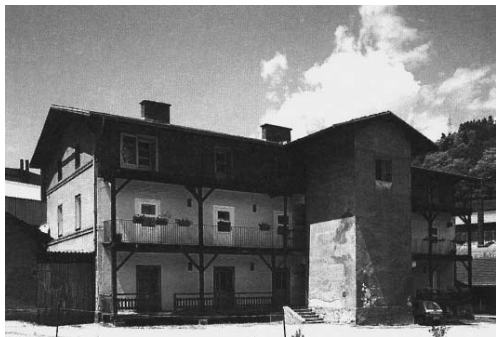
Stanovanja za delavce 463
